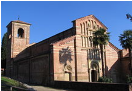
Veduta d'insieme della chiesa e del campanile
