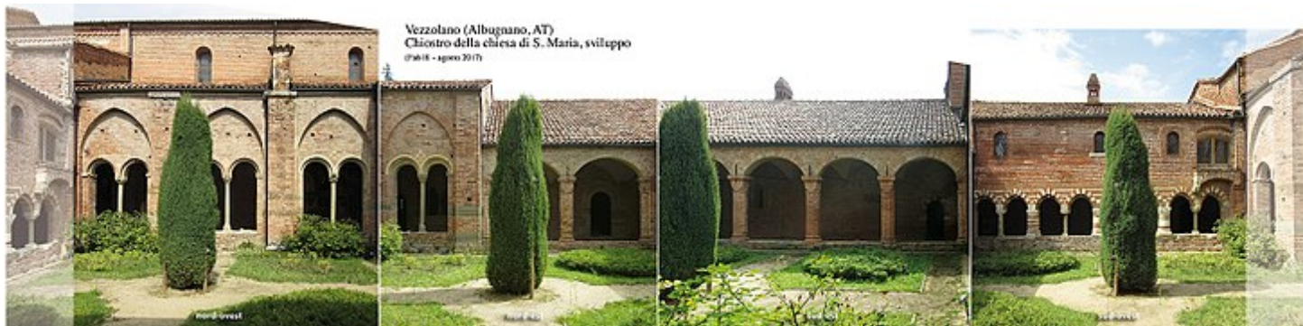
Chiostro dell'abbazia di Vezzolano, sviluppo dei quattro lati (NO, NE, SE e SO).
